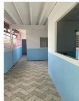
Corredor de acesso
