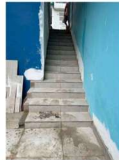
Escada de acesso ao piso inferior
